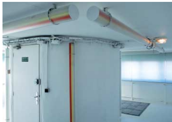
L'escalier de secours a été investi par des luminaires
